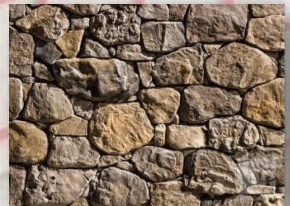
Muratura in pietrame
