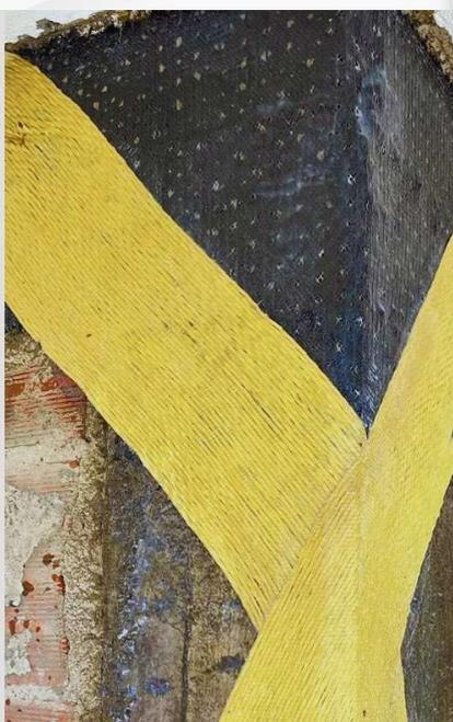
*Sulla base delle sopracitate Linee Guida, OLYMPUS ha sviluppato un sistema di consolidamento strutturale, basato sull'utilizzo di materiali FRP ed FRCM, che permette di migliorare sismicamente un edificio in c.a. lavorando unicamente sull'involucro esterno dell'edificio.*
