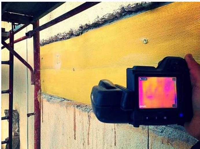
Nel corso degli anni, questo tipo di fibra polimerica ha ricevuto miglioramenti notevoli in termini di resistenza meccanica. Con il tempo si è arrivati a prodotti sempre più resistenti, che offrono un rapporto di almeno 5:1 sull'acciaio ed è molto resistente anche alla temperatura.
